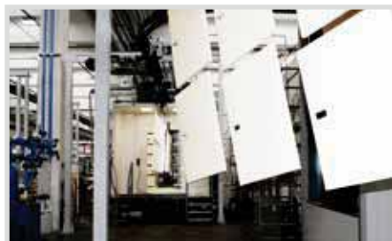
ÁREA DE PINTURA CABINAS
